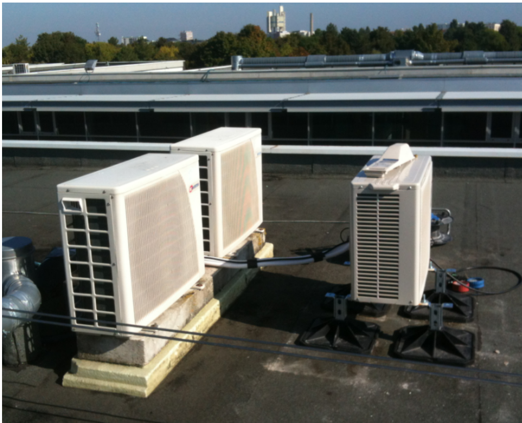
Figure 3 - site d'installation en toiture terrasse
