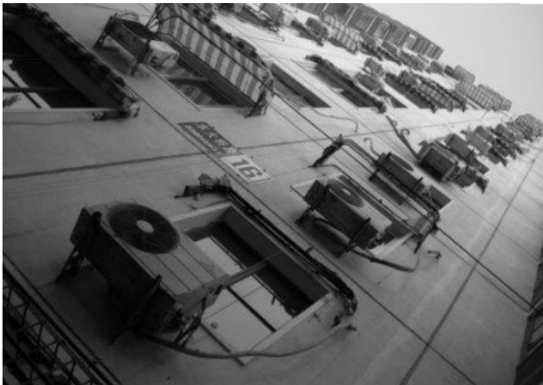
Figure 1 - Climatiseurs moyenne puissance sur une façade d'immeuble asiatique
