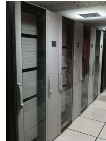
Racks confinés et échangeurs intégrés
